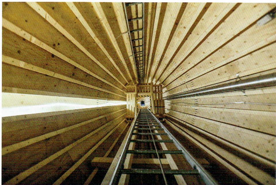
La première tour éolienne en bois est installée depuis près d'un an en Suède, sur l'île de Björkö au large de Göteborg.
